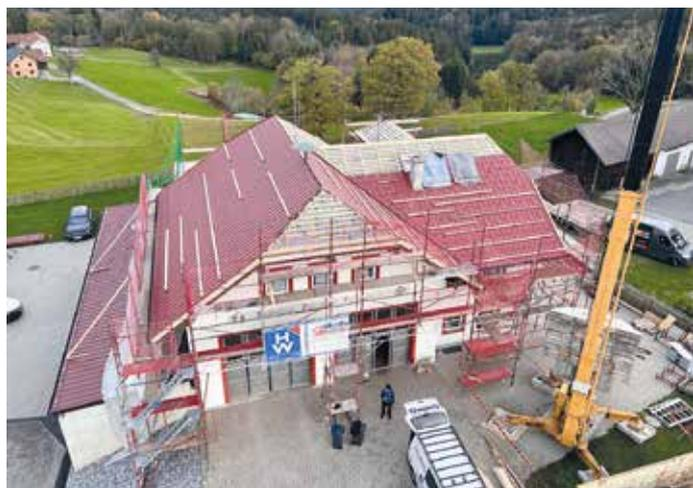
Bei den Diskussionen für das neue Dacheindeckungssystem musste man Themen wie Gewicht und Widerstandsfähigkeit des Materials sowie die Statik der gesamten Dachkonstruktion berücksichtigen, daher fiel die Entscheidung schließlich auf Aluminium-Dachplatten. Die Auftragsvergabe in der Gemeinderatssitzung vom 10. März 2022 an die Firma Hütter & Wagner GesmbH aus Altheim ebnete den Weg für die Umsetzung der Arbeiten im Herbst dieses Jahres.
