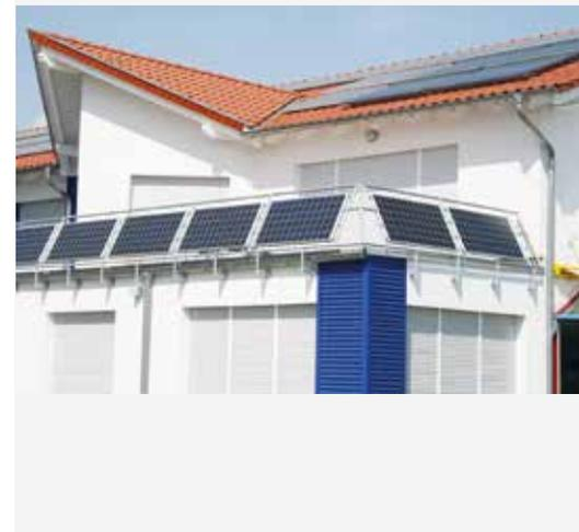
Diese Mini-PV-Anlagen schalten sich bei Stromausfall bzw. Stromabschaltung sofort aus. Das machen sie auch wenn sie von der Steckdose getrennt werden, sodass an den Stiften des Steckers keine Spannung mehr anliegt.
